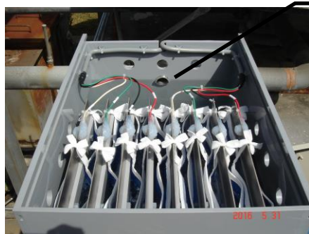
電気分解槽(上視図)
